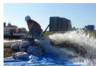
排水ポンプ車による排水
