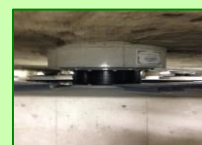
技術見学会(免震装置の見学)
