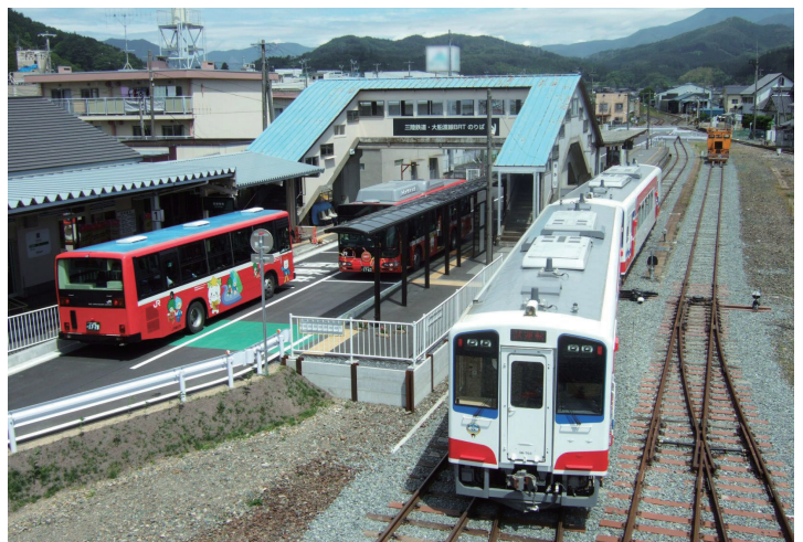
東日本大震災の被害から仮復旧として線路上に敷設されたJR東日本の大船渡線BRTと三陸鉄道南リアス線。鉄道駅ホームにBRTが乗り入れる「盛駅」 写真提供/東日本旅客鉄道(株)
