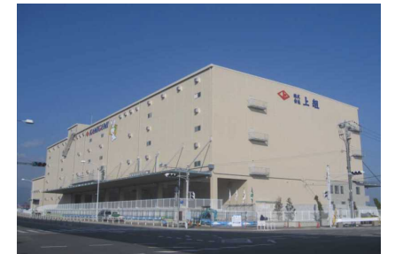
※写真は神戸港で既に営業中の同型の倉庫(KALC)
