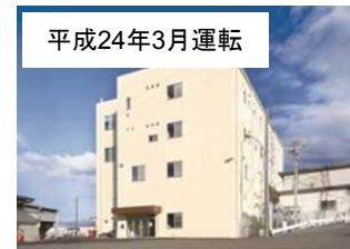
松阪市リサイクルセンター (資源ゴミ等の処理施設)
