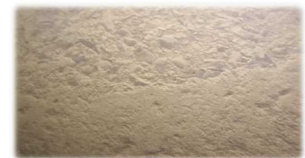
写真5. 貯水池の堤体コンクリートの状態 (深度約20m)
