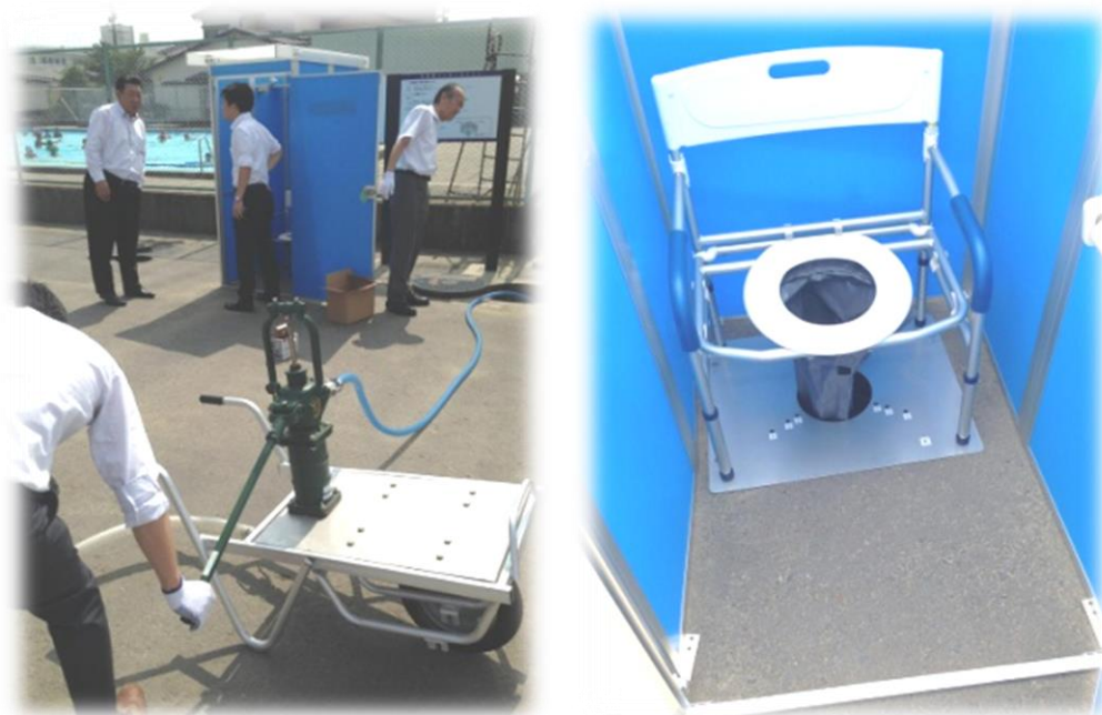
東松島市のマンホールトイレ（写真左：トイレ外観と送水ポンプ、写真右：トイレ内部）
