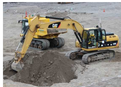
掘削・積込作業状況
