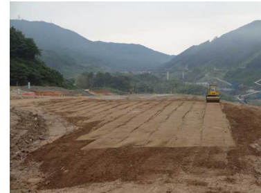
自律制御による転圧作業状況
