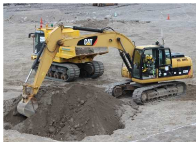
掘削・積込作業状況
