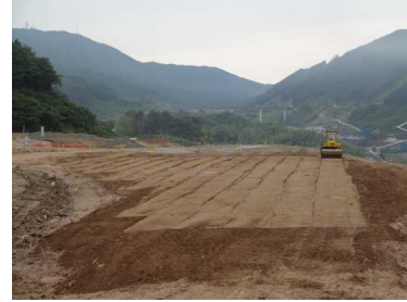
自律制御による転圧作業状況
