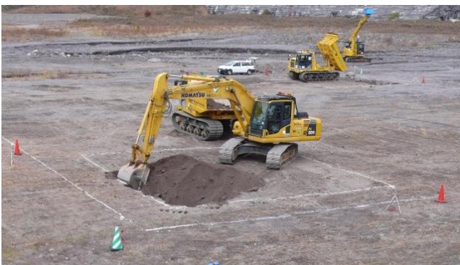
掘削・積込状況
