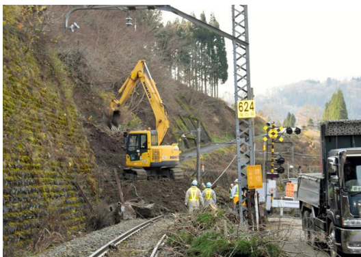
片切掘削状況
