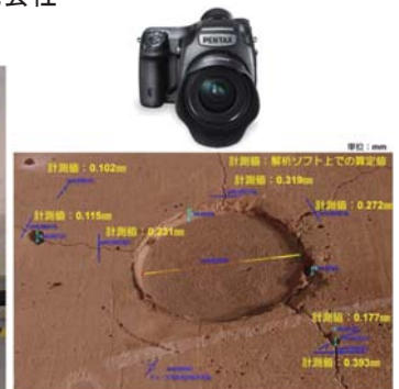
高精細デジタルカメラとコンクリート壁面(3Dモデル)
