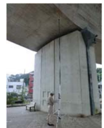
支承部の点検
