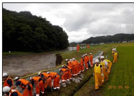
宇都宮市 田川左岸(関堀町地先) 改良積み土のう(土留鋼板使用)
