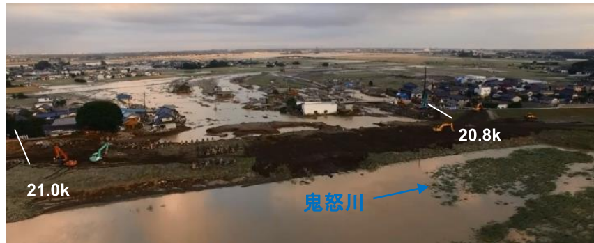
応急復旧状況(9/12)
