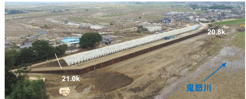
応急復旧状況(9/24)
