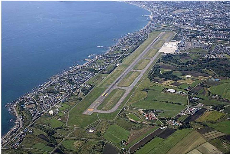
■函館空港の全景
