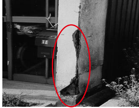
(例5) 外壁が破損している。
