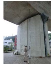
支承部の点検
