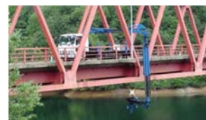
橋梁下面点検
