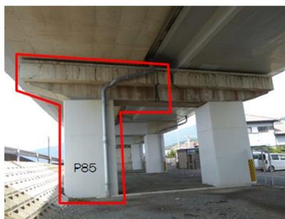
現場検証点検範囲（橋脚・支承,狭隘部）
