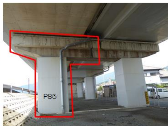
現場検証点検範囲（橋脚・支承,狭隘部）
