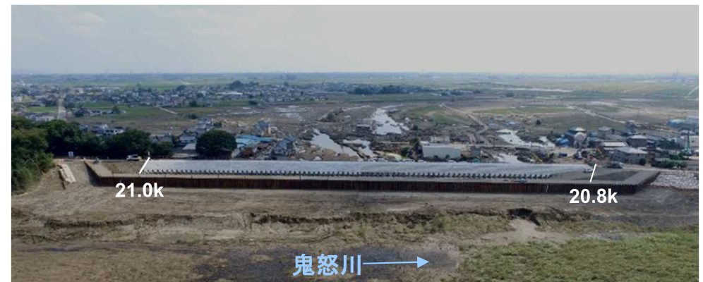
応急復旧完了後の状況(9/27)
