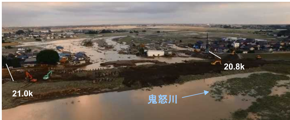
応急復旧状況(9/12)
