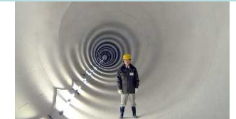
下水道による雨水貯留管の整備(名古屋市)
