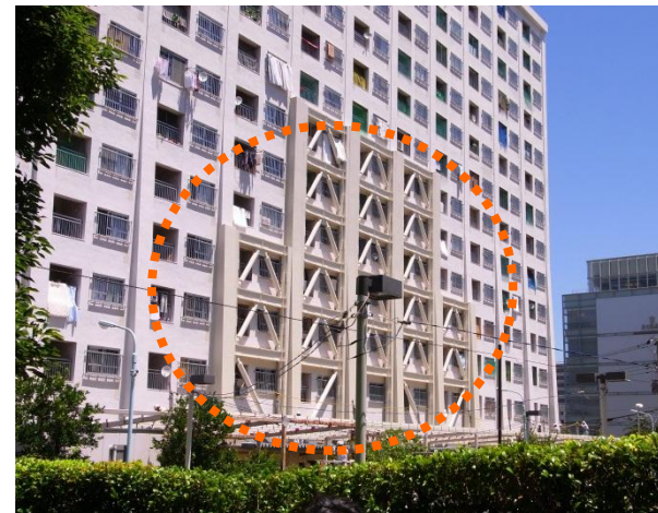
耐震ブレースによる補強
