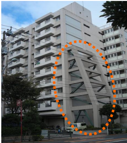
建物妻側にバットレスを設置
