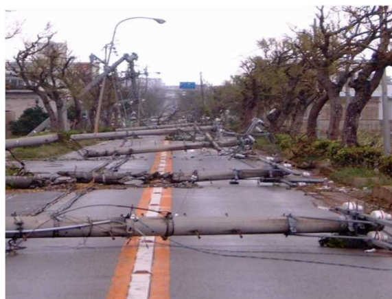
<電柱の倒壊による道路閉塞>
