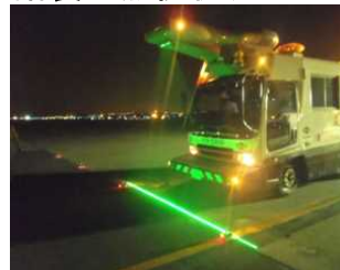
舗装の点検状況
