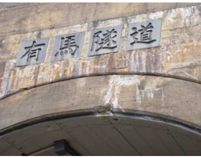
ひび割れのたたき落とし
