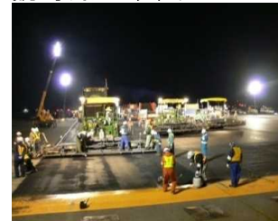
誘導路の改良
