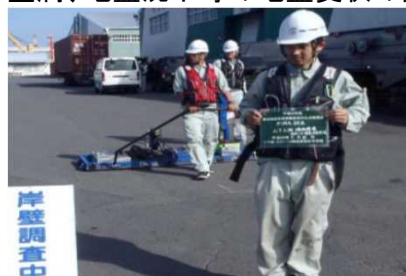
岸壁の地盤変状の計測の様子
