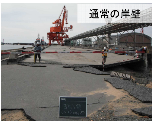
東日本大震災における耐震強化岸壁と通常の岸壁の被災状況
