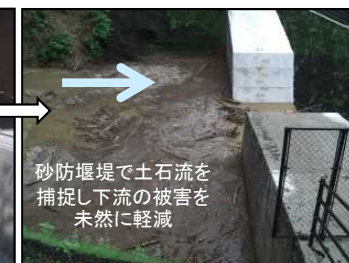
土石流発生後
