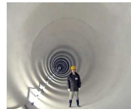
下水道の整備
