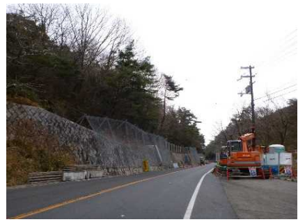
落石防護柵の設置
