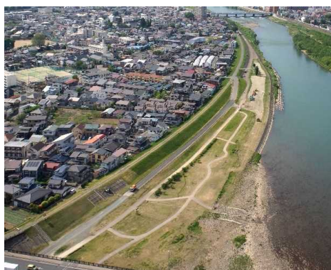
河川堤防の整備
