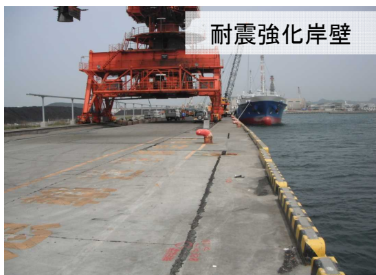
東日本大震災における耐震強化岸壁と通常の岸壁の被災状況
