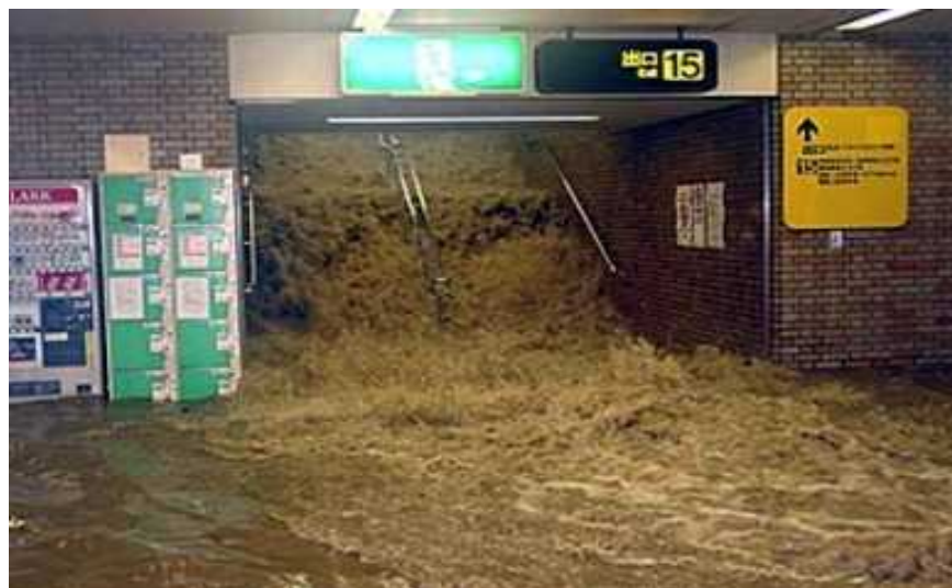
地下鉄の浸水(H15.7博多駅)
