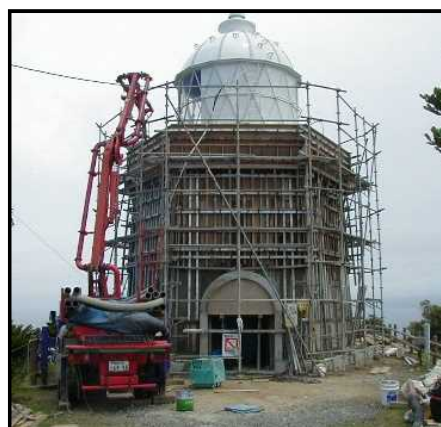
▲鉄筋コンクリート等を用い 建物及び基礎の補強を実施
