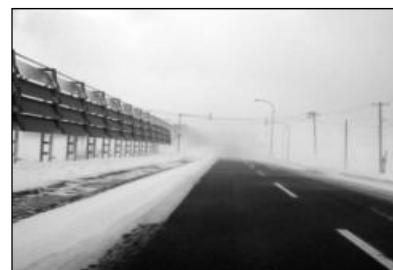
防雪柵の設置
