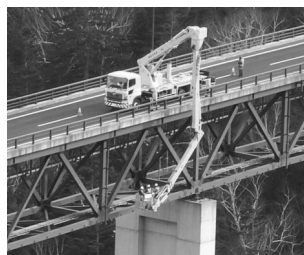
道路構造物の点検状況
