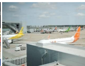
成田空港・第3ターミナル外観 (LCC専用ターミナル) <写真提供: NAA>
