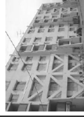
共同住宅 (外付けフレーム補強)
