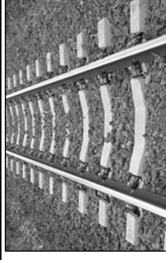
軌道のPCマクラギ化
