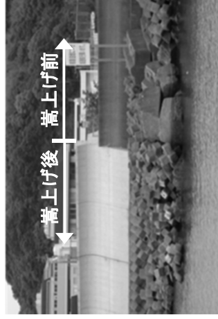
【既設護岸・防潮堤の改良例(嵩上げ)】
