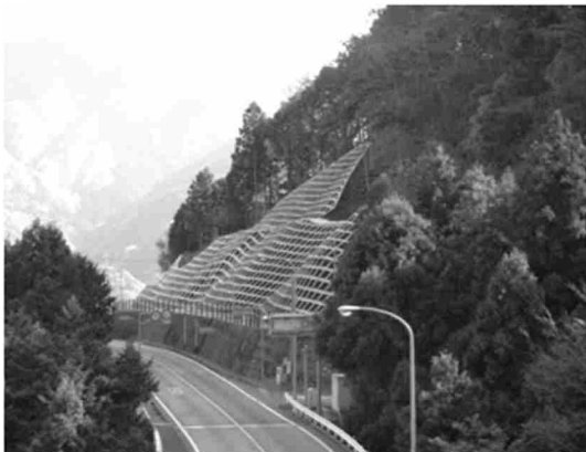
< 斜面崩落防止対策 >
