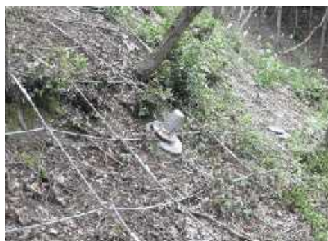
土砂崩壊防止施設(京都市)
