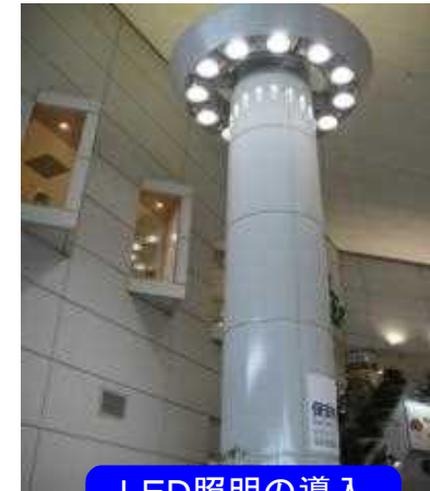
LED照明の導入
