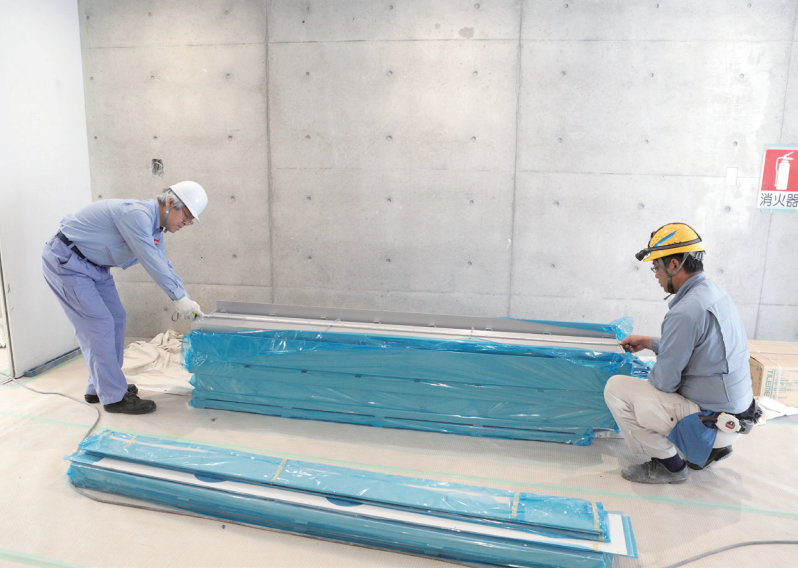
納品された資材が、発注書と誤差がないか測定、確認する。
