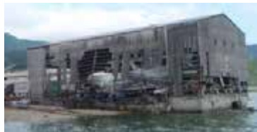
被災直後の大船渡ドック （津波により工場は大破）
