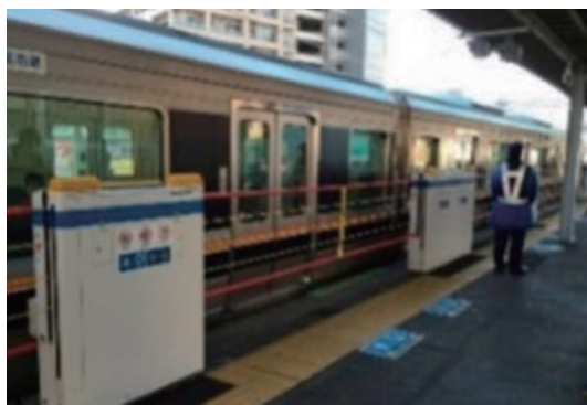
昇降ロープ式ホームドア(支柱伸縮型)
