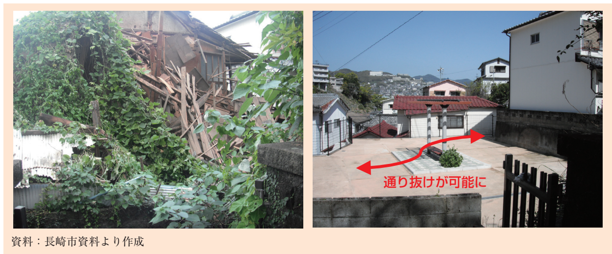
図表3-3-3 除却前の空き家と除却後の空間活用
