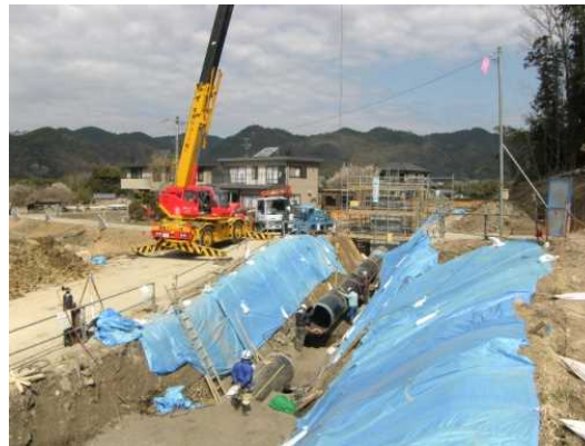
PC管の改築状況(1)
