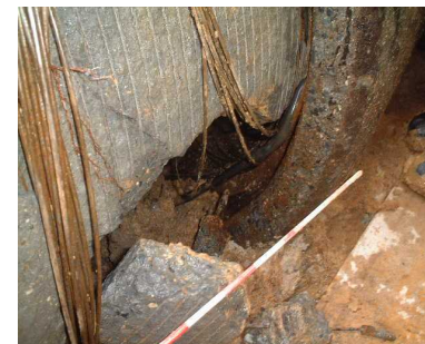
老朽化したPC管の破損状況(左:カバーコートモルタルの剥離・PC鋼線の破断、右:管体破裂状況)
