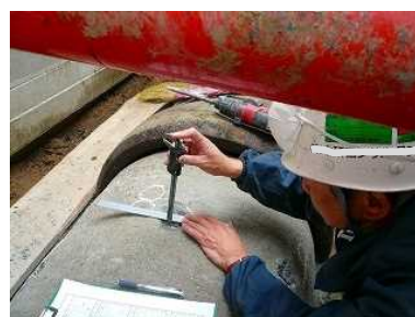
カバーコートかぶり厚計測
