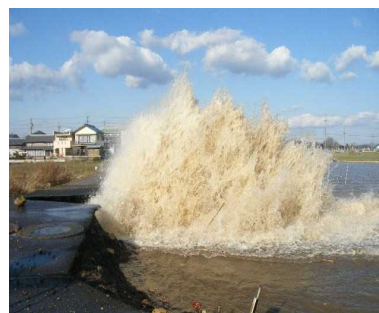
管体破裂による出水被害
