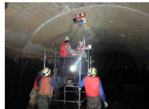
レーダー法調査状況
