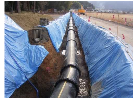
PC管の改築状況(2)
