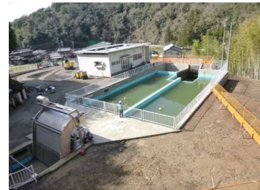
沈砂池新設(上流側から撮影)
