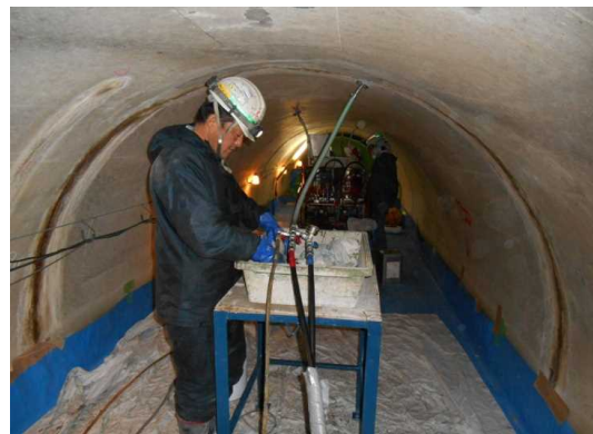
トンネルの改築状況(背面空洞 充填材注入状況)
