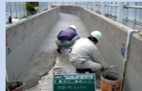
ポリマーセメントモルタルによる補修
