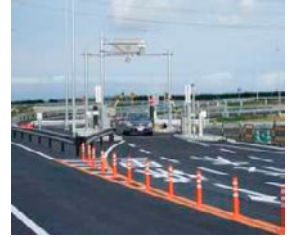
水戸北スマートIC (常磐自動車道)
