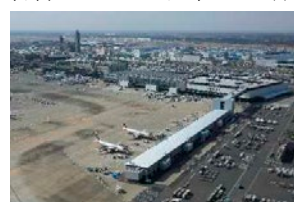
成田国際空港第3ターミナル （提供：成田国際空港株式会社）
