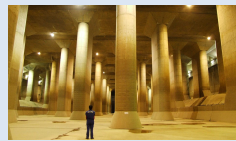
首都圏外郭放水路
