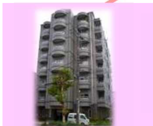
○高齢者向け優良賃貸住宅 (H18) 共同住宅 (35戸)、 デイケア施設
