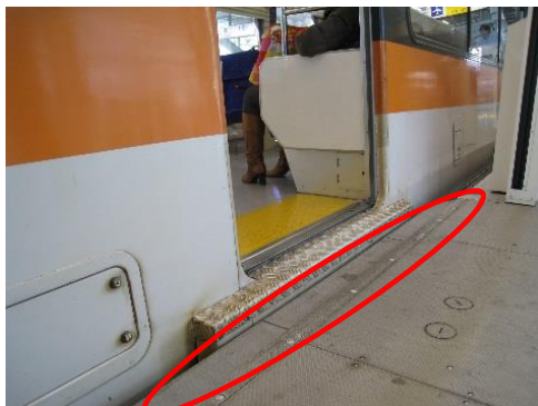
【ホームドアと連動した可動ステップの設置】
