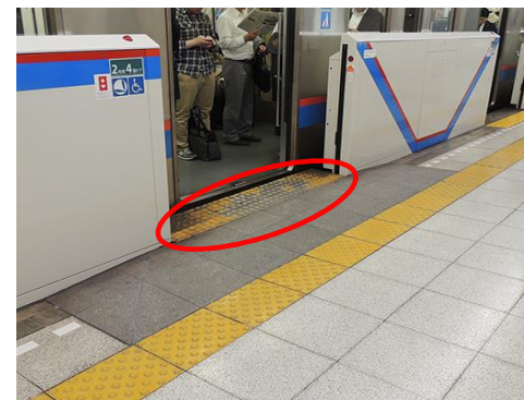
〔ホームドアの設置に併せた スロープの設置
