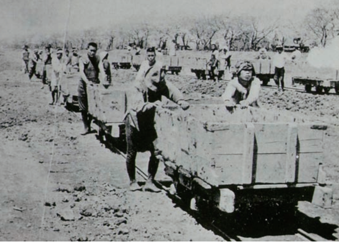
荒川放水路をつくるため、掘った土をトロッコで運ぶ人々。工事は工程によって蒸気機関車や蒸気船なども使われたが、現在と比べると人力の作業の比率が大きかった。この工事で掘った土は2180万 m 3（東京ドーム18杯分）にも及んだ。
