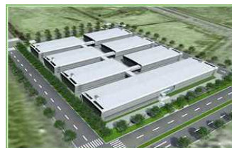
さくらインターネットデータセンター 全棟完成イメージ
