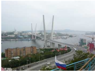
道内企業が参画したウラジオストク市内の斜張橋 出典：富山県ホームページ
