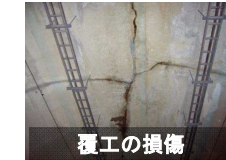
橋脚コンクリートの損傷
