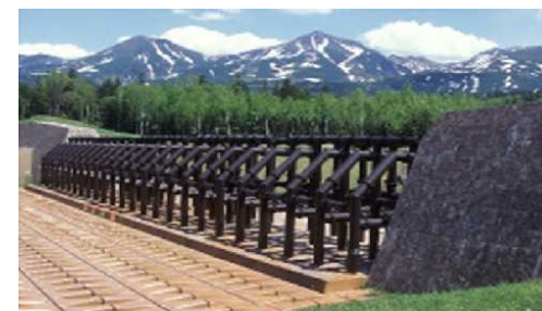
砂防えん堤(十勝岳火山砂防)
