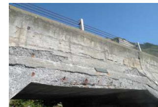
■ 複合劣化による損傷事例
