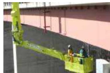
橋を点検する技術者
