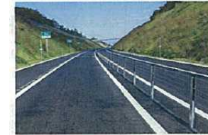
低コストで導入可能なワイヤーロープ式防護柵などを効果的に整備
