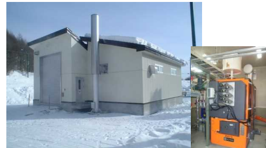
【ボイラ室の外観】
