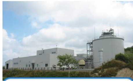
【稚内市バイオエネルギーセンターの外観】
