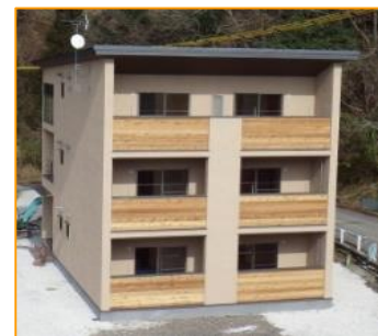
▲ CLTを利用した3階建て共同住宅(大臣認定第1号)
