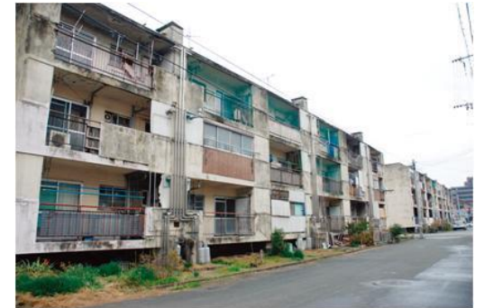
共同住宅の空き家
