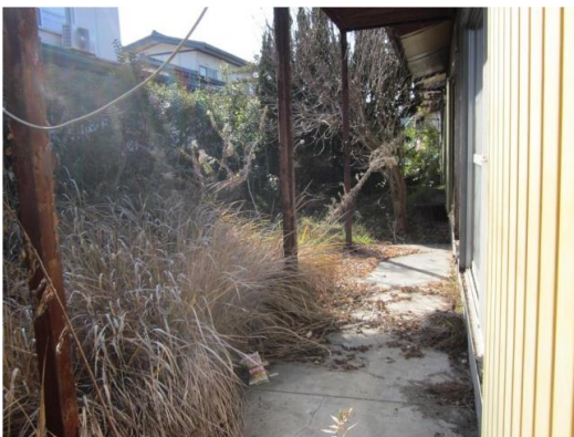
雑草が繁茂した空き家
