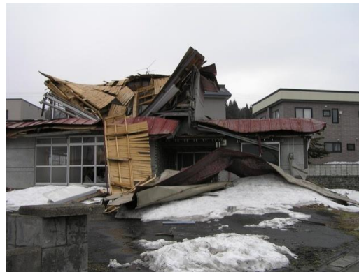
積雪により屋根が落下した空き家
