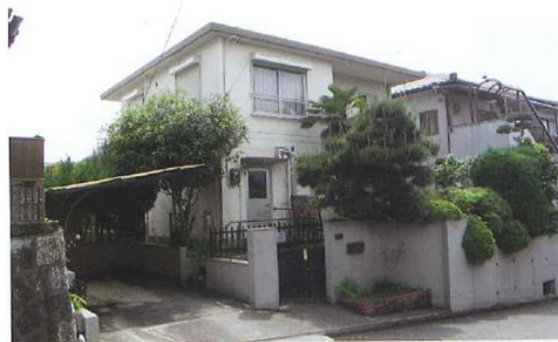
まだ使用できる空き家
