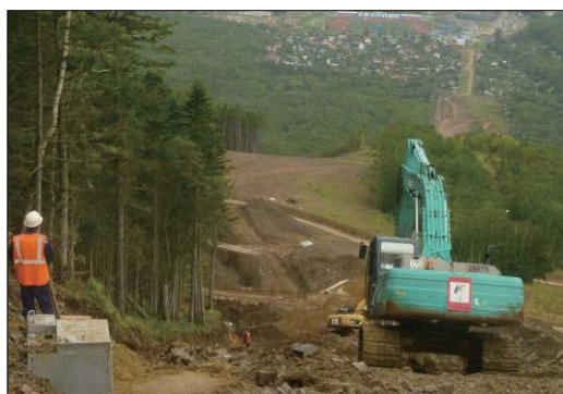
人工降雪施設建設工事（ユジノサハリンスク）
