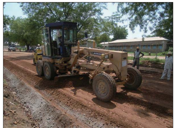
栈橋補強工事（南スーダン共和国）
