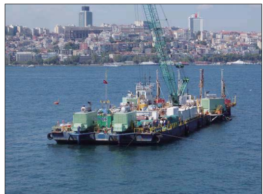
ボスボラス海峡横断沈埋トンネル耐震工事（トルコ）
