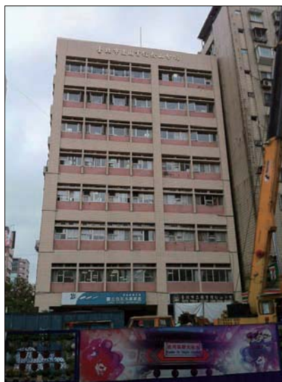
市立図書館分館建物地盤改良工事（台湾）
