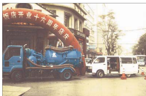
下水道本管洗浄・調査（中国）
