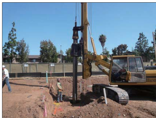
熱交換パイプ（ジオパイプ）の埋設（アメリカ）
