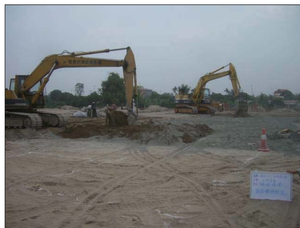
工場新築工事での混合攪拌状況（ハノイ）
