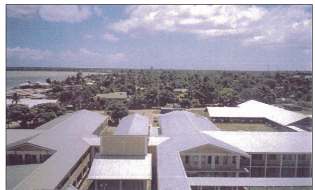
バイオラ病院防水工事（トンガ王国）
