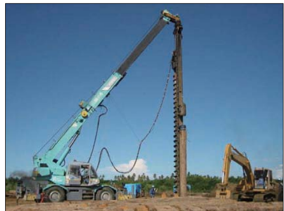
杭基礎工事（ガイアナ共和国）
