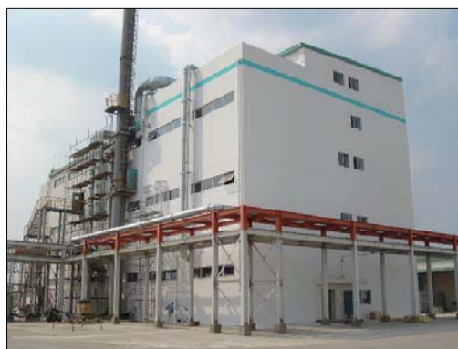
塗料製造プラント工場増設一式工事（中国）
