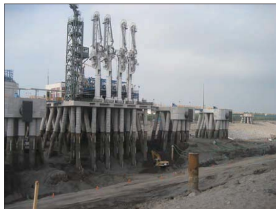
マンザニージョ橋建設工事（メキシコ）
