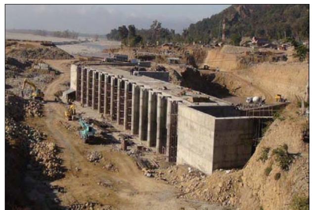
灌漑頭首工工事（ネパール）
