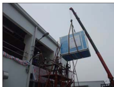
空調設備設置工事（ベトナム）
