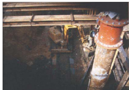
SWP 工法による掘削現場 (韓国)
