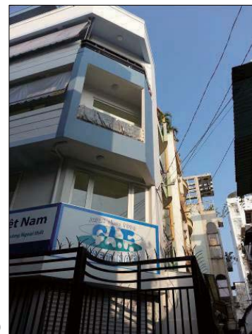
オフィス兼賃貸住宅 新築工事（ベトナム）
