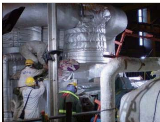
発電所定期点検改造工事（香港）
