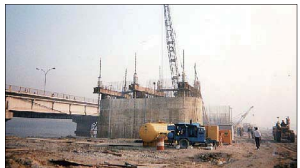
ニザムディン橋梁下部工事（インド）
