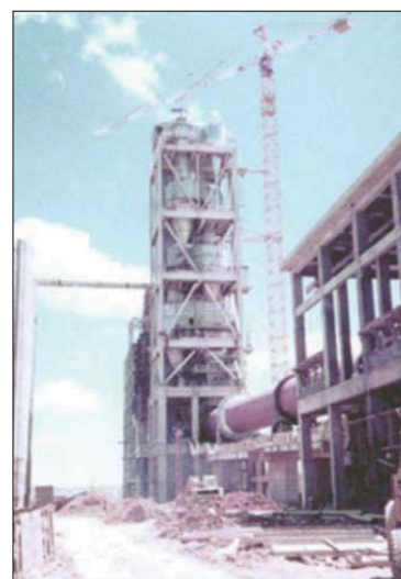
セメントプラント全工場設備工事（アルジェリア）
