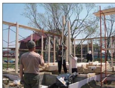
北方型住宅建設現場（サハリン）
