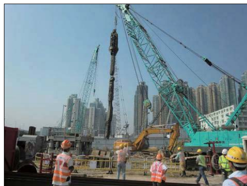
既存杭撤去工事（香港）
