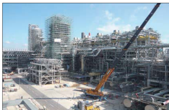
石油化学プラント建設工事（東南アジア）
