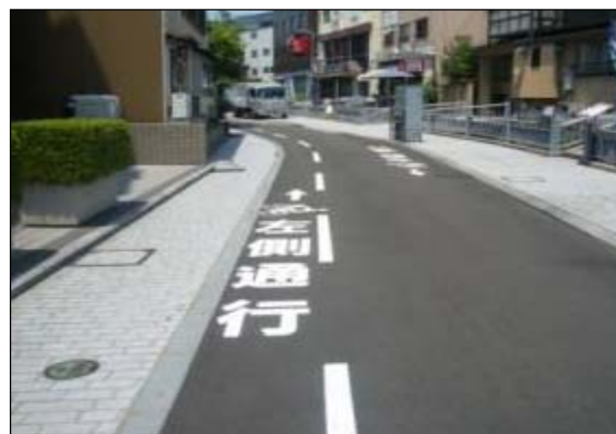
写真10 分かりやすい路面表示の設置
