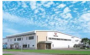
カルビーポテト株式会社 本社・帯広工場
