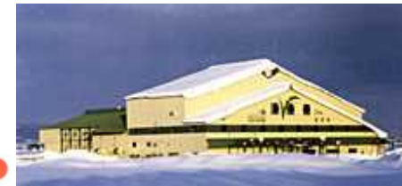
沼田町米穀低温貯留乾燥調製施設 (スノークールライスファクトリー)
