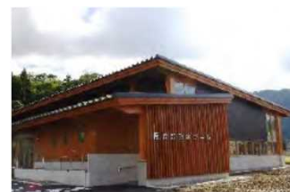
町民プール(厚沢部町)
