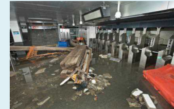
地下鉄駅の浸水状況 ©MTA
