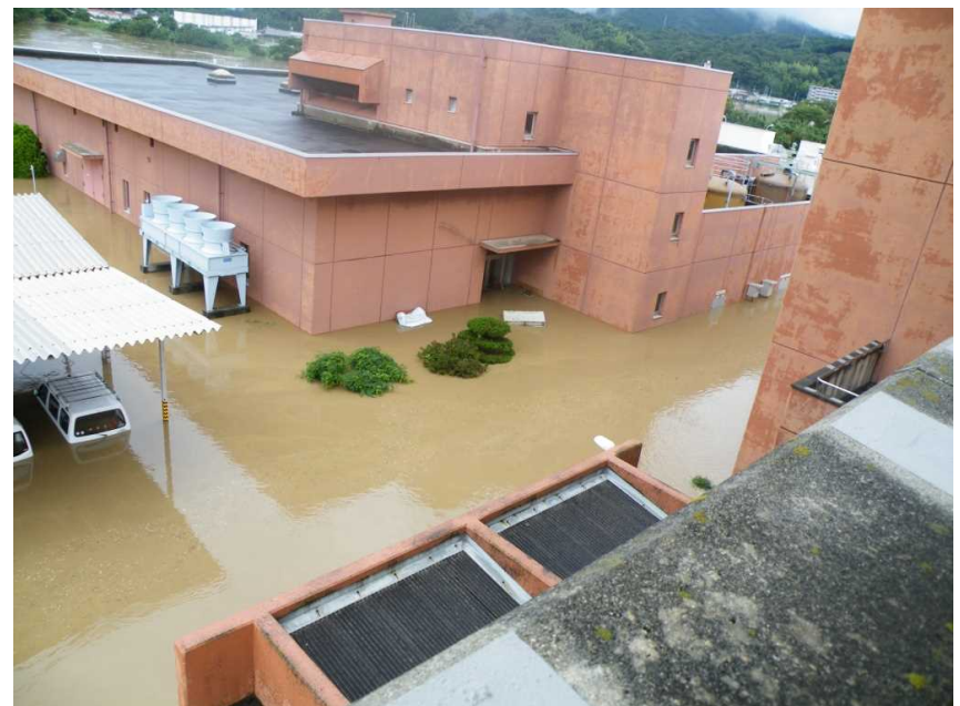
平成21年7月中国・九州北部豪雨 朝田浄水場被害状況
