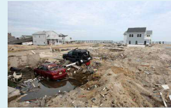
沿岸部の家屋損壊状況 ©USACE
