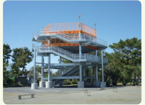
南海トラフ地震に備え高知県四万十市にできた津波タワー
