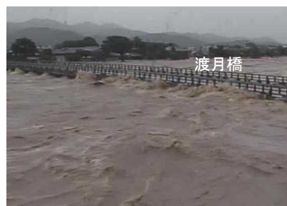
渡月橋の欄干まで水位が上昇した桂川 （京都市嵐山地区）
