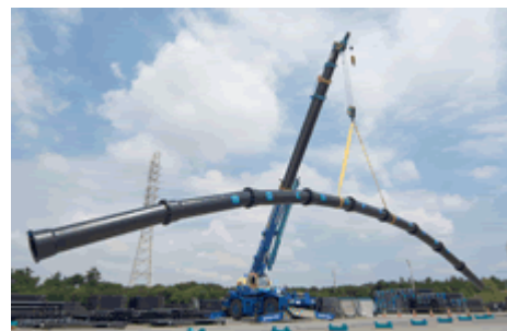
柔軟に曲がる管を使用することにより、耐震化を図る
