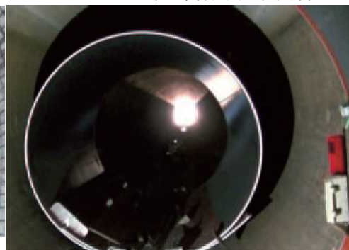
サイホン内に鋼管を挿入し補強
