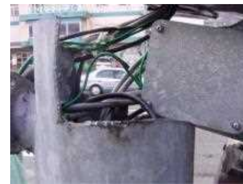
疲労き裂の影響も疑われる倒壊事例 ＜国土技術政策総合研究所資料より転載＞
