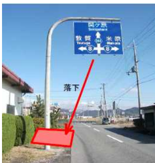
吊り下げ式標識の吊金具折損により標示板が落下した事例 ＜H25.11.20 滋賀県長浜市で発生した事案＞
