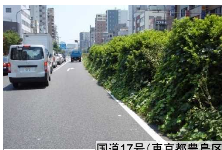
国道17号(東京都豊島区)
