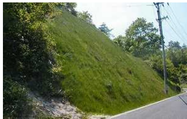
切土(法面保護)
