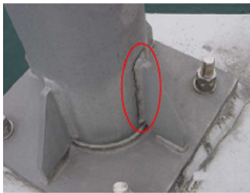
金属疲労による損傷事例 ＜門型標識等定期点検要領より転載＞
