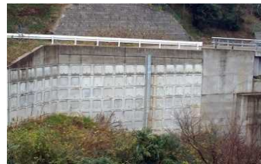
盛土(補強土壁)
