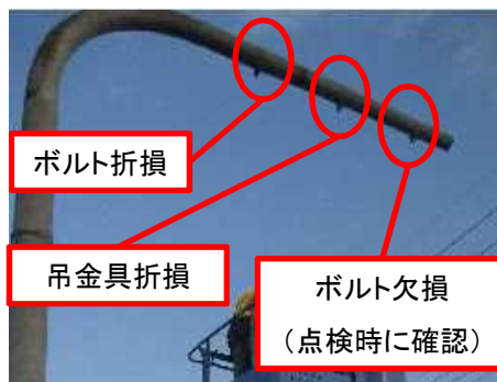
吊り下げ式標識の吊金具折損により標示板が落下した事例 ＜H25.11.20 滋賀県長浜市で発生した事案＞
