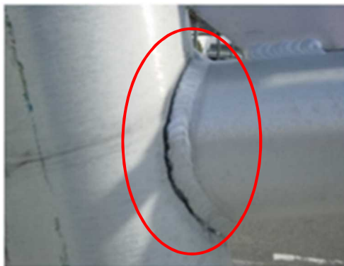
金属疲労による損傷事例 ＜門型標識等定期点検要領より転載＞
