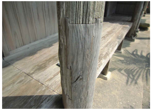
▲ 継ぎが施された柱
