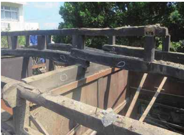
▲ 梁・柱の状態チェック
