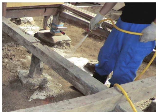
防蟻・防腐剤の散布 ▶
