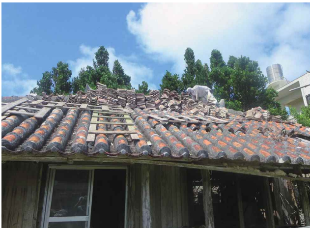
▲ 屋根瓦の撤去
